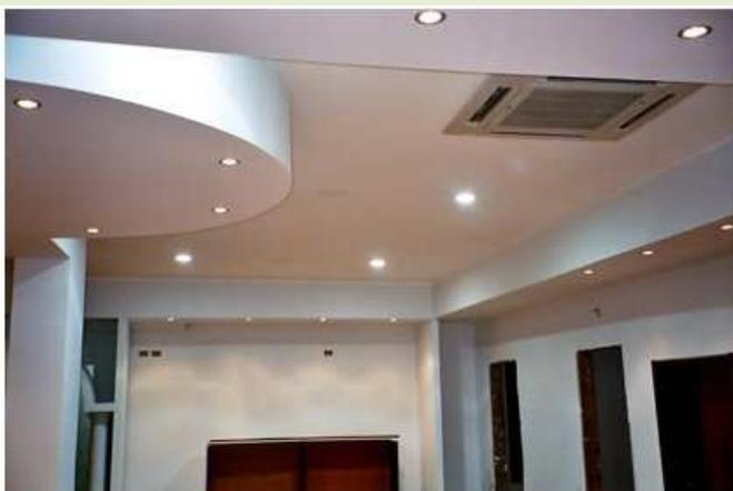
Figura 5.14: Esempio di controsoffitto chiuso non ispezionabile.
