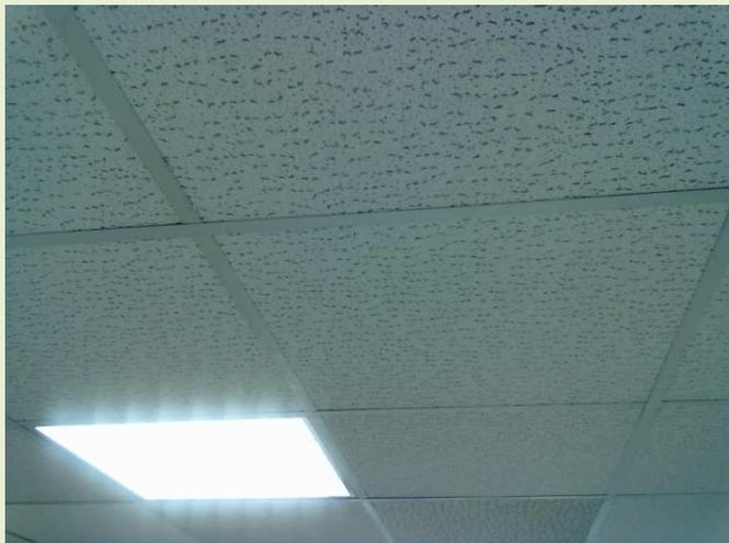
Figura 5.17: Esempio di controsoffitto aperto ispezionabile.
