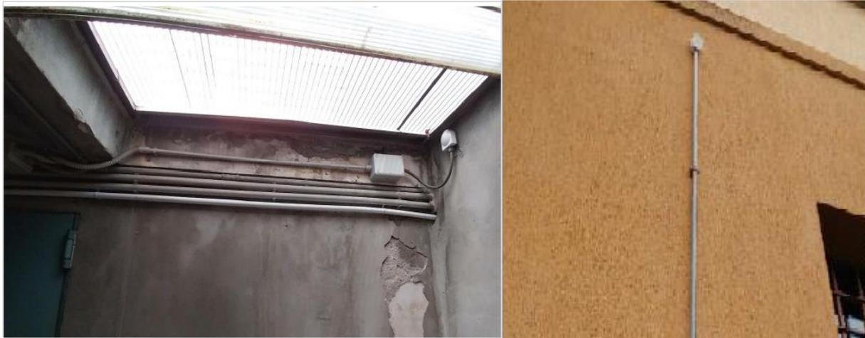
*Regolazione tramite sonda climatica collocata in locale centrale termica a contatto con l'aria esterna e tramite sonda climatica posta in facciata*
