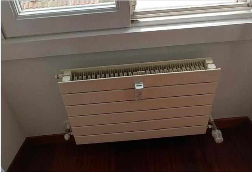
*Regolazione ambiente tramite valvole termostatiche*
