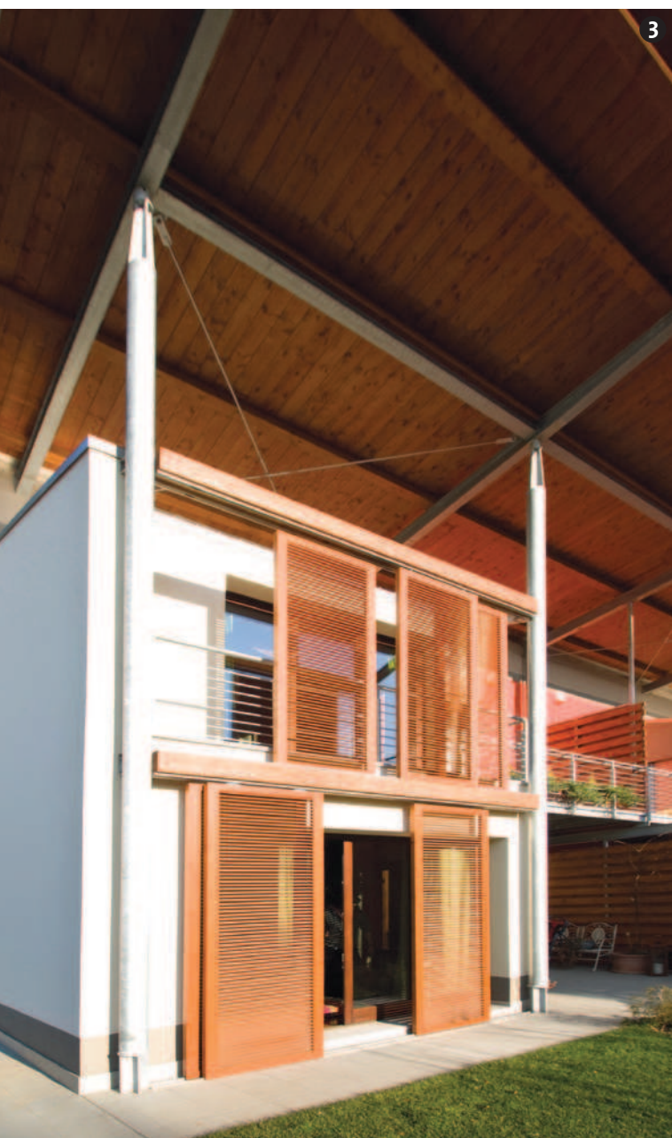
3. Dettaglio facciata sud – South façade detail
